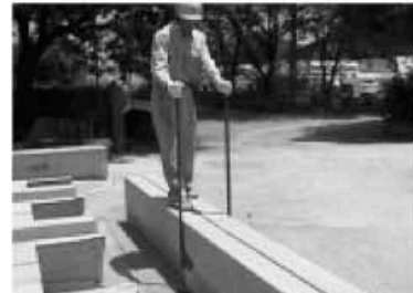
③ パイプの差し込み・引き寄せ
