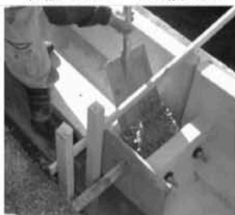
間詰コンクリート打設状況
