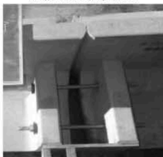
連結ボルト接続状況
