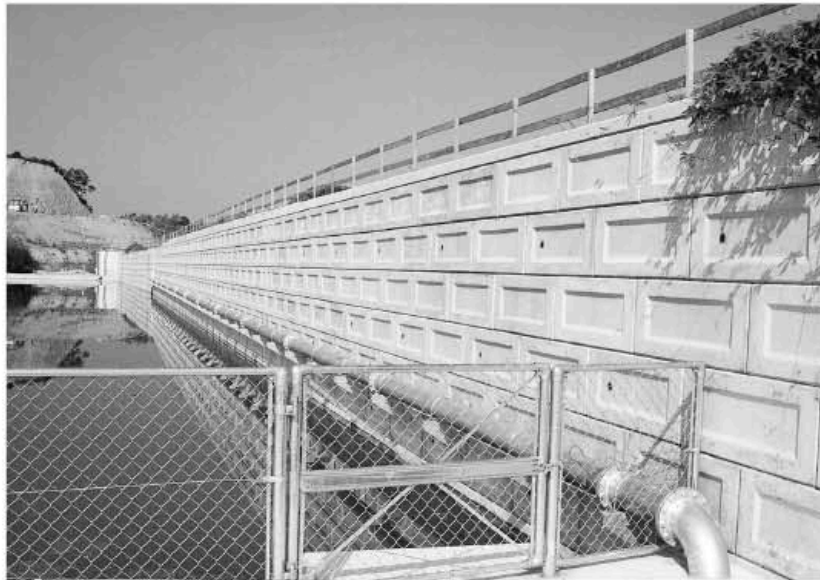
国土交通省 香川工事事務所 池戸改良工事
