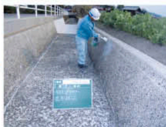
④ プライマー工 (欠損不陸整正) 注3
