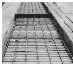
2 KCフォームの上に配筋した状態
