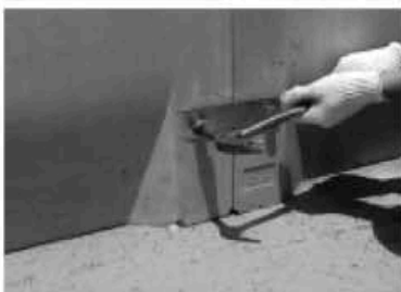
④ ボルト打ち込み
