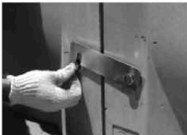
④ ボルト打ち込み
