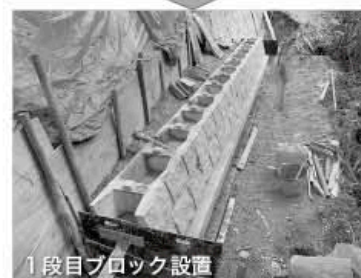
基礎ブロック設置
