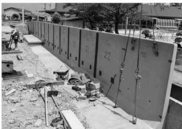
施工中 埋戻し側
