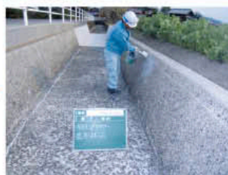
④ プライマー工 (欠損不陸整正) 注3
