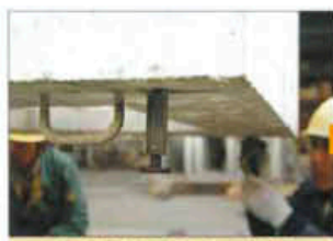
高さ固定ボルトの取付
