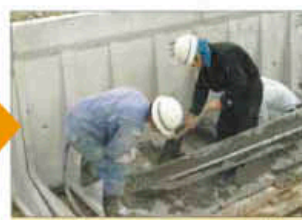
後打ちコンクリート打設
