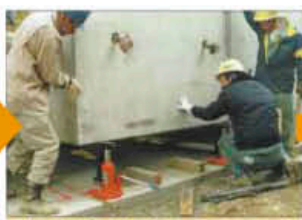
安全用角材のセット(3ヶ所) 及び据付・ジャッキ調整
