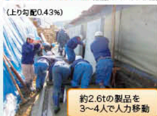
⑦ マルチスライド工法（製品のスライド移動）⑧ 製品据付完了
