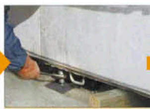
鉄板のセット(3ヶ所) 及び高さ固定ボルトの調整
