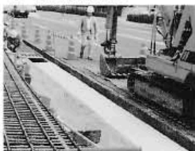
1 既設の側溝の蓋掛り部にKCフォームを置いた状態
