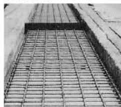
2 KCフォームの上に配筋した状態
