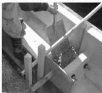
間詰コンクリート打設状況
