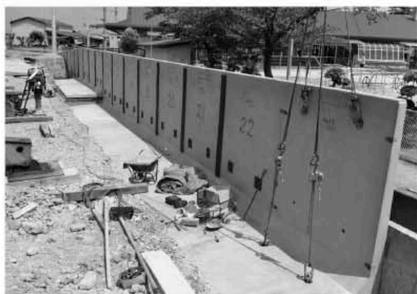
施工中 埋戻し側
