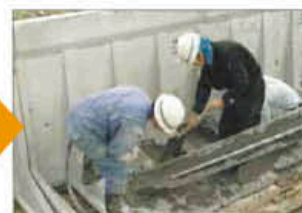
後打ちコンクリート打設
