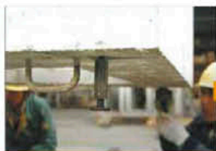
高さ固定ボルトの取付
