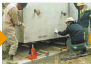
安全用角材のセット(3ヶ所) 及び据付・ジャッキ調整
