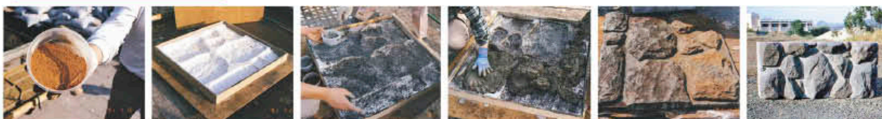
(1) アート顔料 (2) 散水した型枠 (3) アート顔料の散布 (4) モルタル(コンクリート)の打設 (5) 完成
