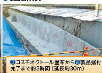
⑦ マルチスライド工法（製品のスライド移動）⑧ 製品据付完了
