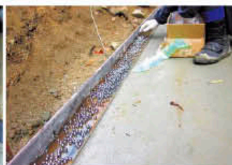
⑦ マルチスライド工法（製品のスライド移動）⑧ 製品据付完了
