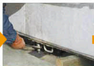
鉄板のセット(3ヶ所) 及び高さ固定ボルトの調整
