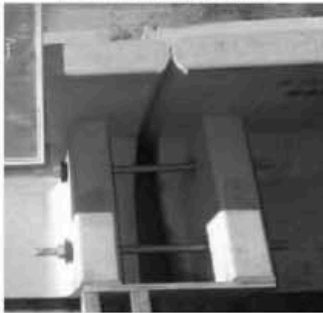
連結ボルト接続状況
