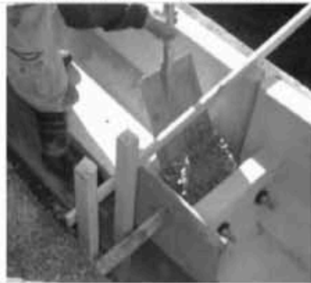
間詰コンクリート打設状況
