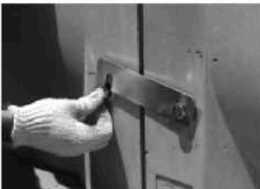
④ ボルト打ち込み
