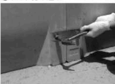
④ ボルト打ち込み
