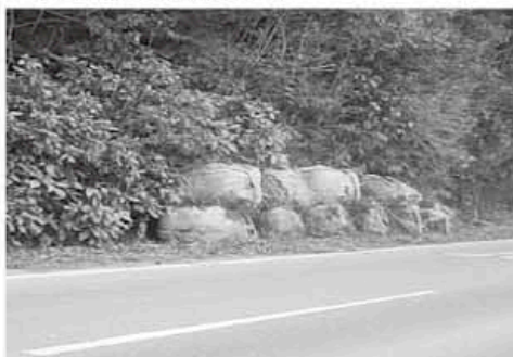
施工前：大型土のう
