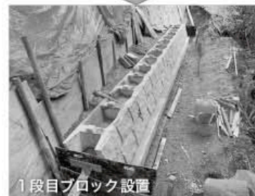
基礎ブロック設置
