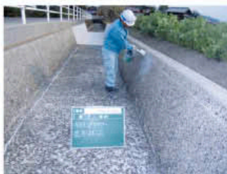
④ プライマー工 (欠損不陸整正) 注3
