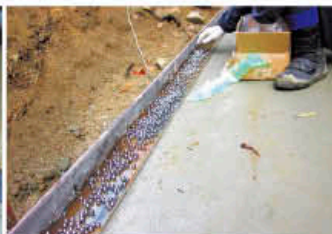
⑦ マルチスライド工法 (製品のスライド移動)
