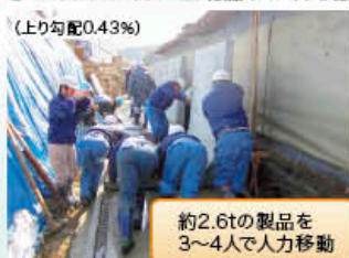
⑦ マルチスライド工法 (製品のスライド移動)
