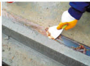
⑦ マルチスライド工法 (製品のスライド移動)
